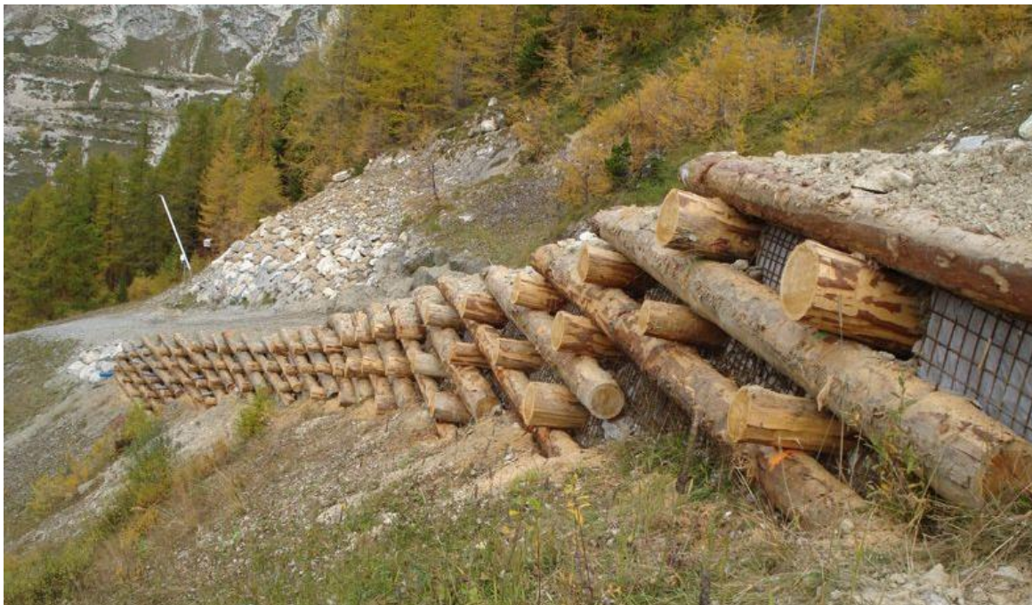
Photographie 2 : Exemple de soutènement en gabion bois
