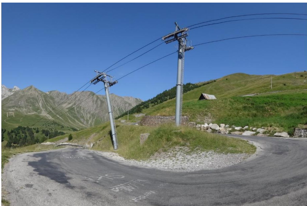
Figure 35 : très forte visibilité des pylônes au niveau de la route du Col d'Allos
