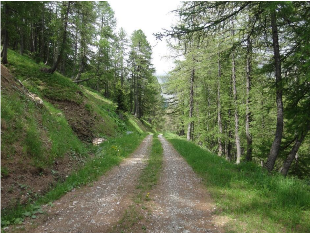
Figure 42 : la piste Forêt, localisée sur une piste forestière existante, sera élargie de quelques mètres, notamment au niveau du talus supérieur.
