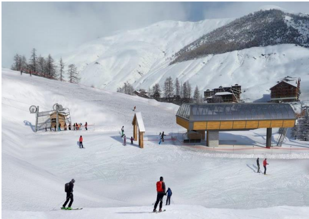
Photographie 1 : Insertion paysagère de la gare aval
