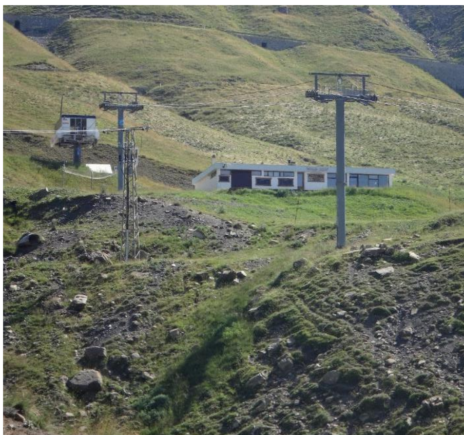
Figure 32 : Vue 4 depuis la route du col d'Allos, sous la gare d'arrivée du TSF Marin Pascal et le restaurant Altitude 2050.
