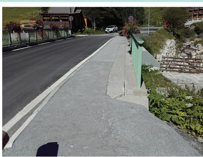
La Foux – Modification des trottoirs et réfection du pont montée aiguille pour permettre l'accès piéton au jardin d'enfant
